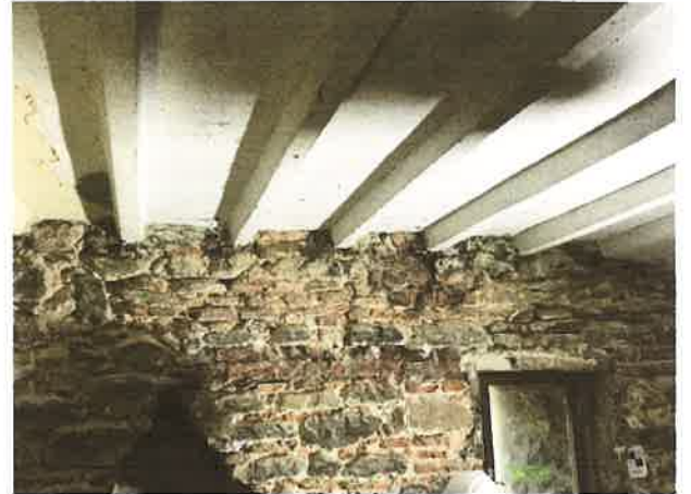
Foto 16. Kule çelik döşeme sistemi
