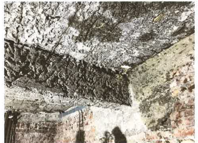
Foto 6. Kule betonarme döşeme sistemi
