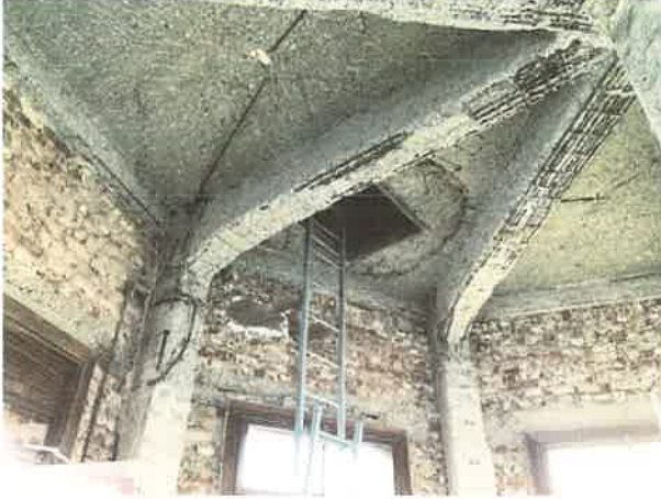
Foto 13. Kule betonarme döşeme sistemi
