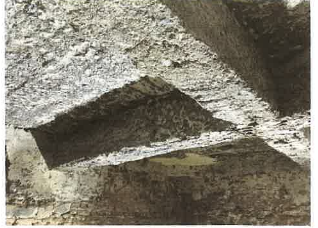
Foto 8. Kule betonarme döşeme sistemi
