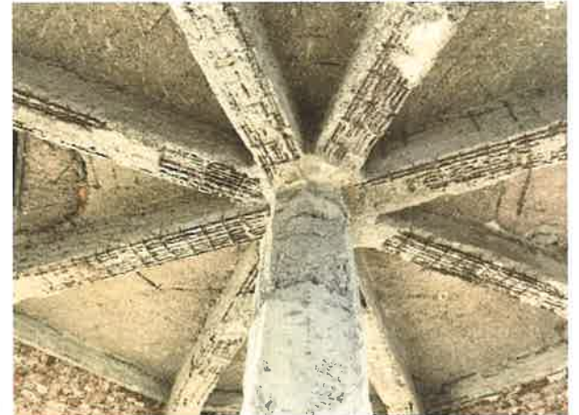
Foto 12. Kule betonarme döşeme sistemi
