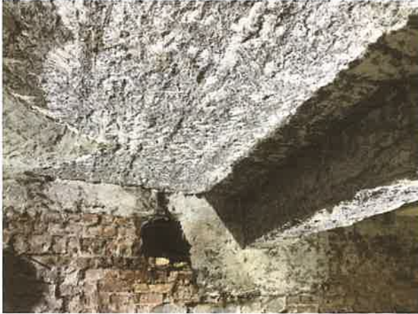
Foto 9. Kule betonarme döşeme sistemi
