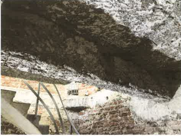
Foto 7. Kule betonarme döşeme sistemi
