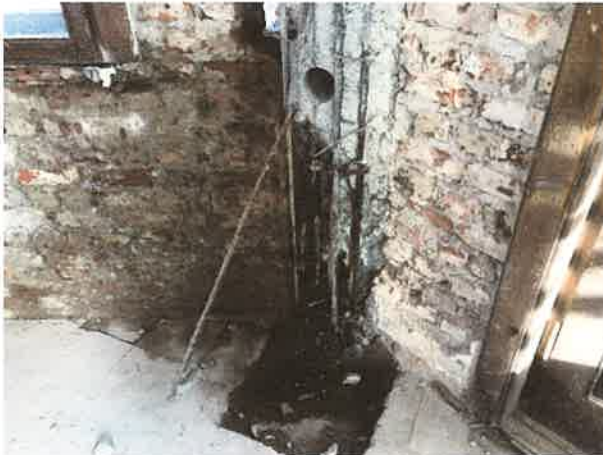
Foto 11. Kule betonarme kolon
