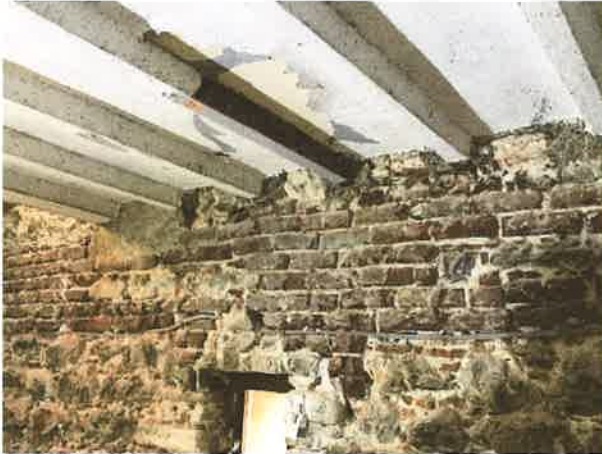
Foto 15. Kule çelik döşeme sistemi
