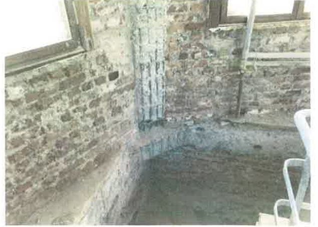
Foto 14. Kule betonarme hatıl-kolon birleşimi
