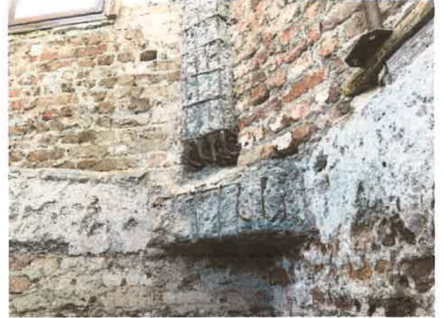
Foto 10. Kule betonarme hatıl-kolon birleşimi
