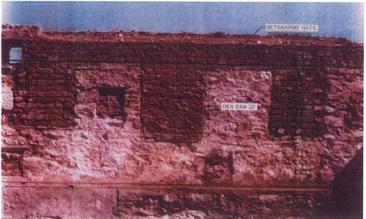
1999 yılındaki sökümler sırasında ortaya çıkan kuzey sur duvarı
