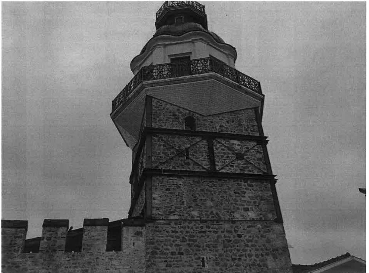
Kulenin dışına yerleştirilen çelik kuşak ve çapraz elemanlar
