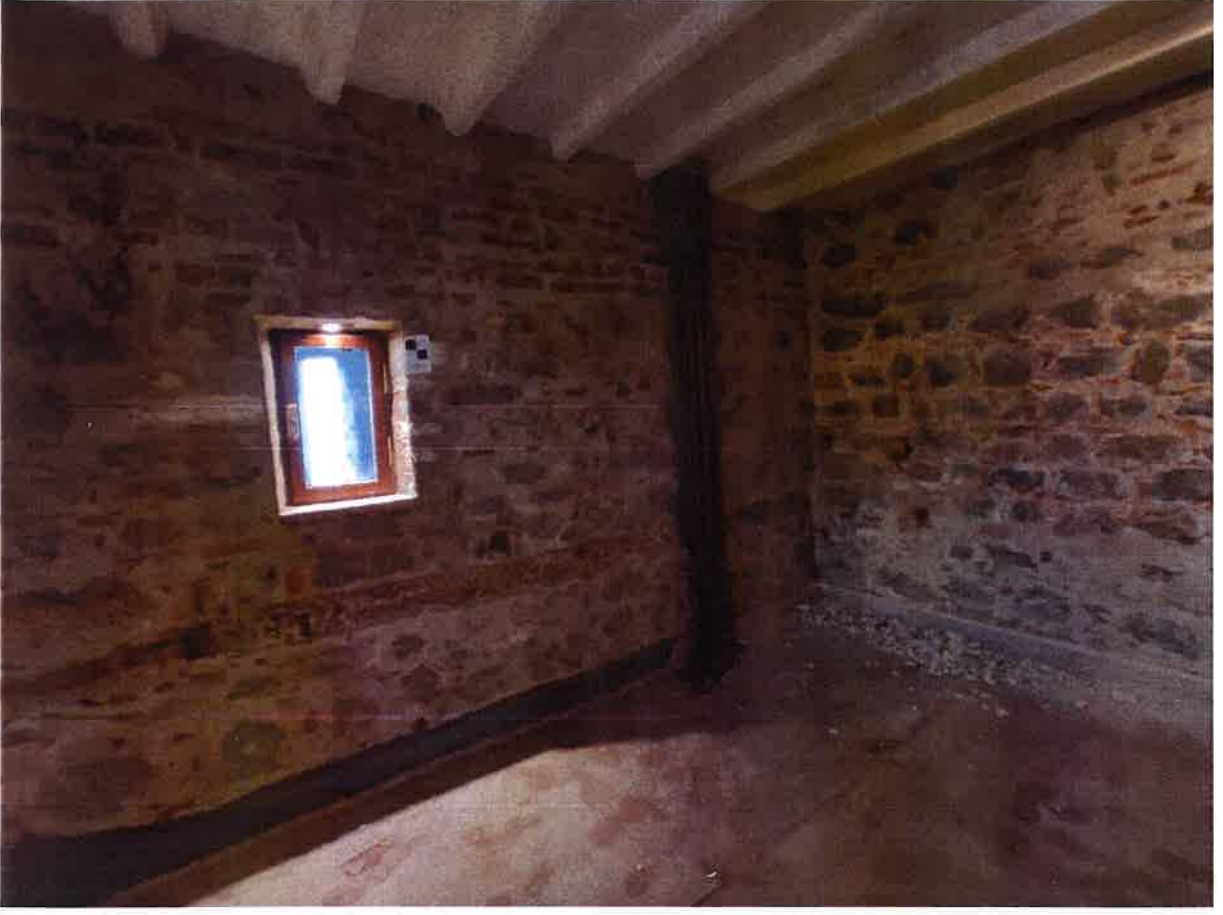
Kârgir duvar ve duvar içindeki ahşap hatıl
