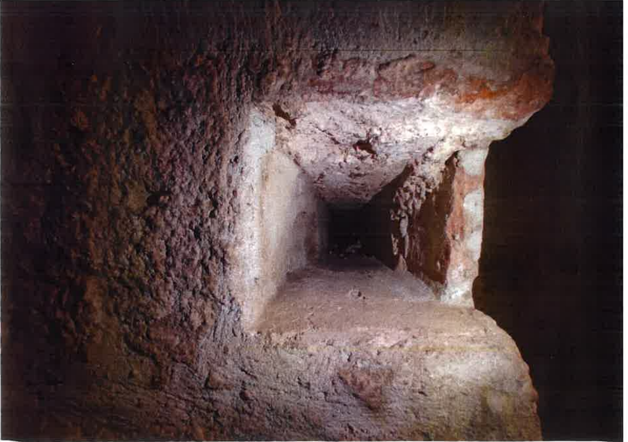
Kârgir duvarlardaki ahşap hatıl boşlukları
