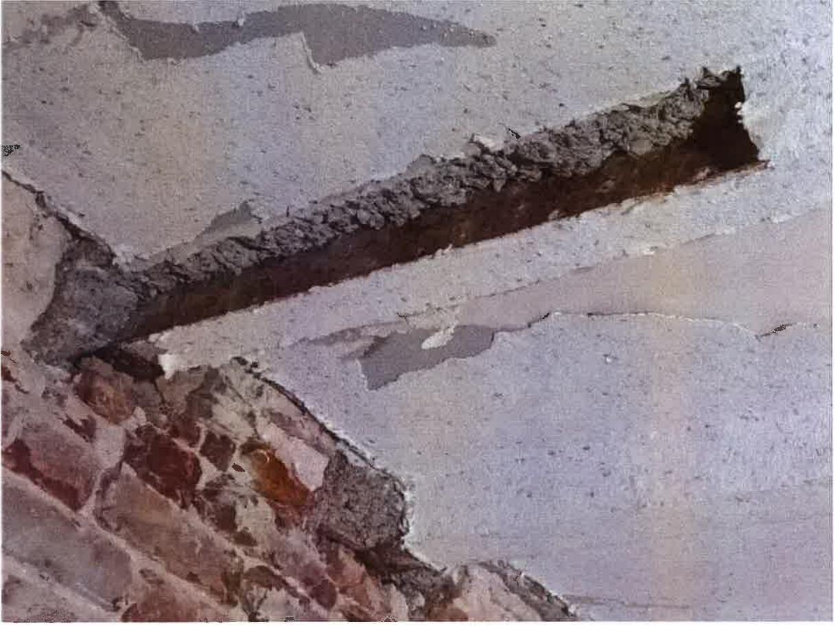
Ara kat döşemelerindeki çelik profiller ve betonarme plak
