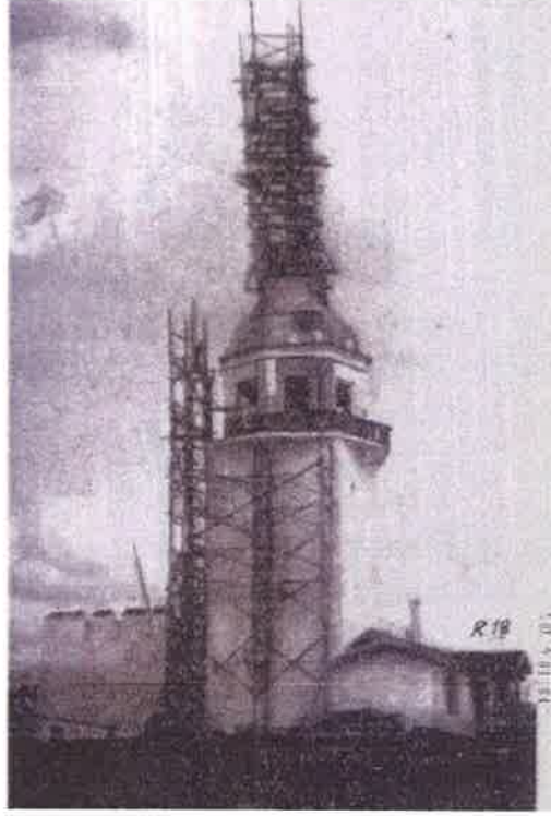
1944 restorasyonu sırasında kulenin fener katlarının yeniden yapımı
