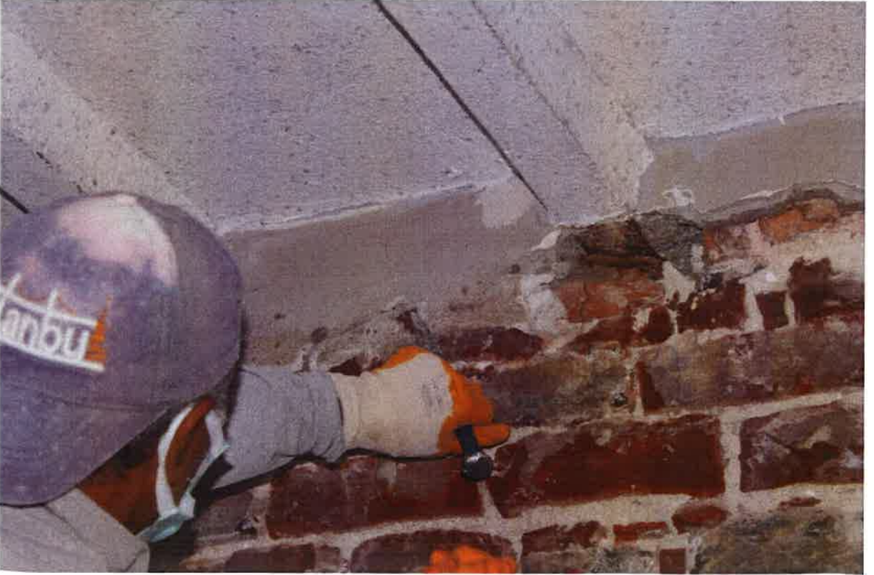
Ara kat döşemelerindeki çelik profillerin mesnetleri
