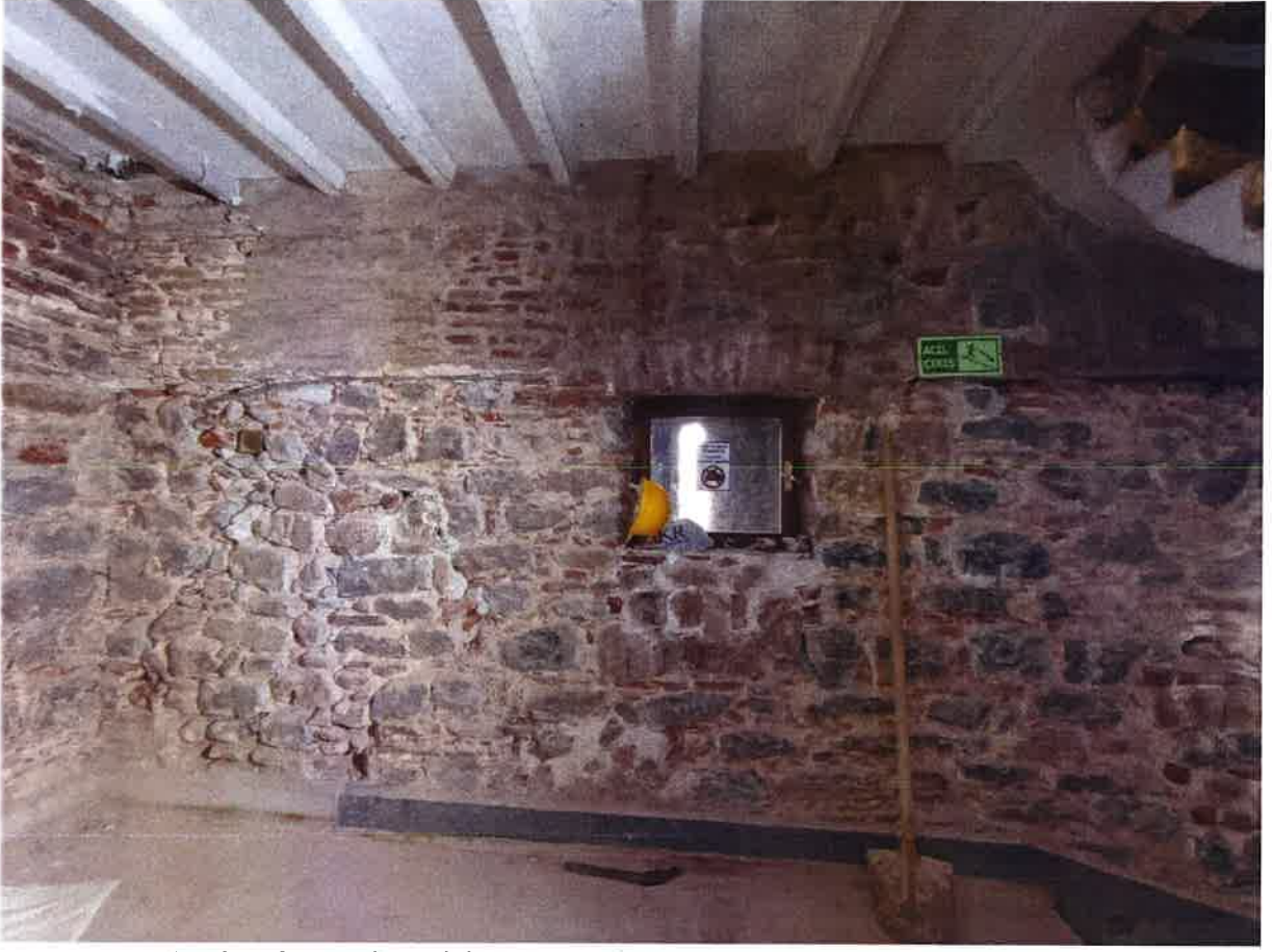
Ara kat döşemelerindeki çelik profilli dişler ve kaba yonu kargir duvar
