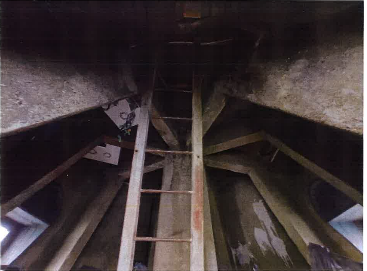
Fenerin 2. Katı, ortadaki kolon ve kabuğu taşıyan kirişler
