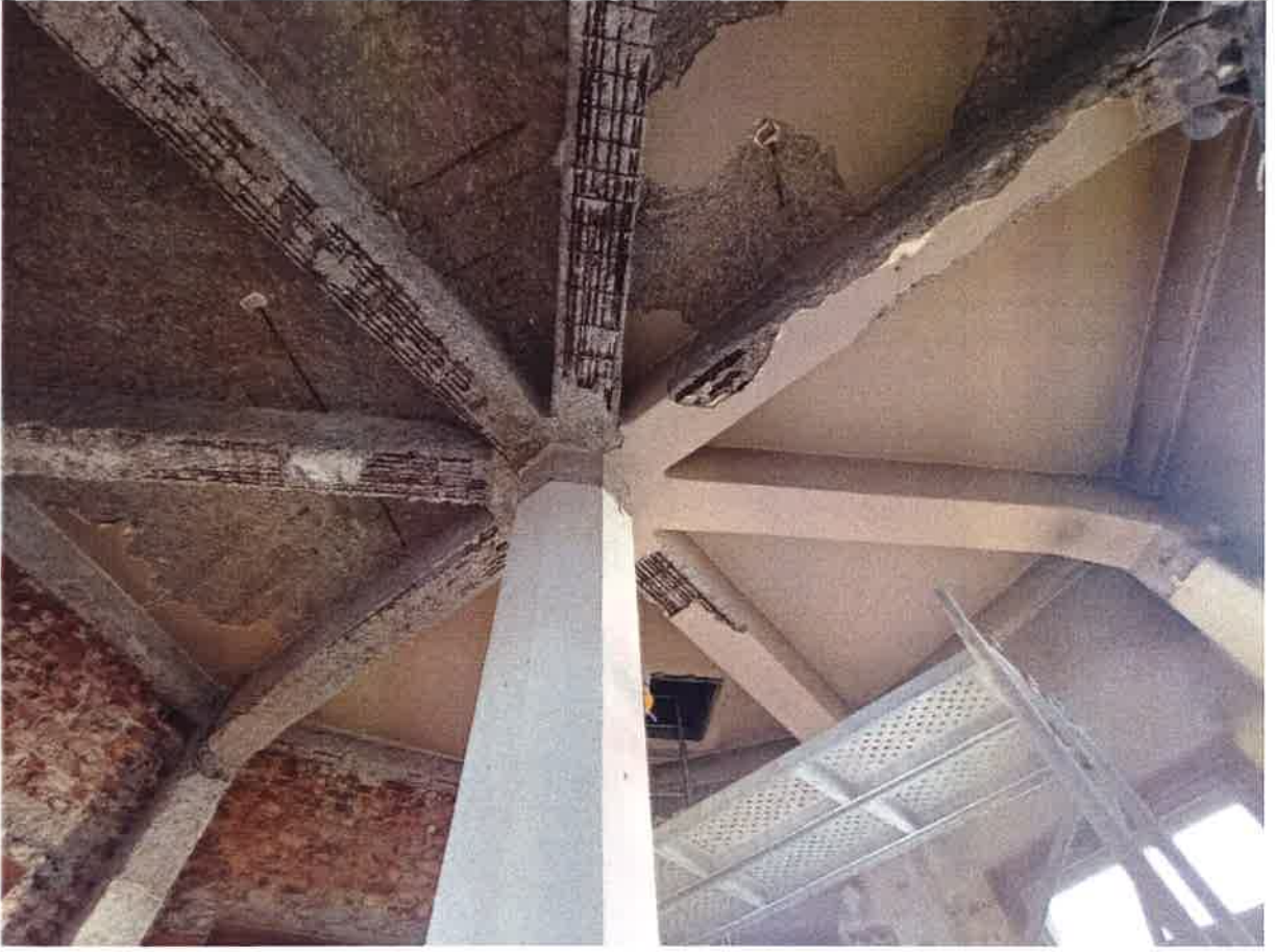
Balkon katında ortadaki kolon ile kenar kolonları birleştiren kirişler
