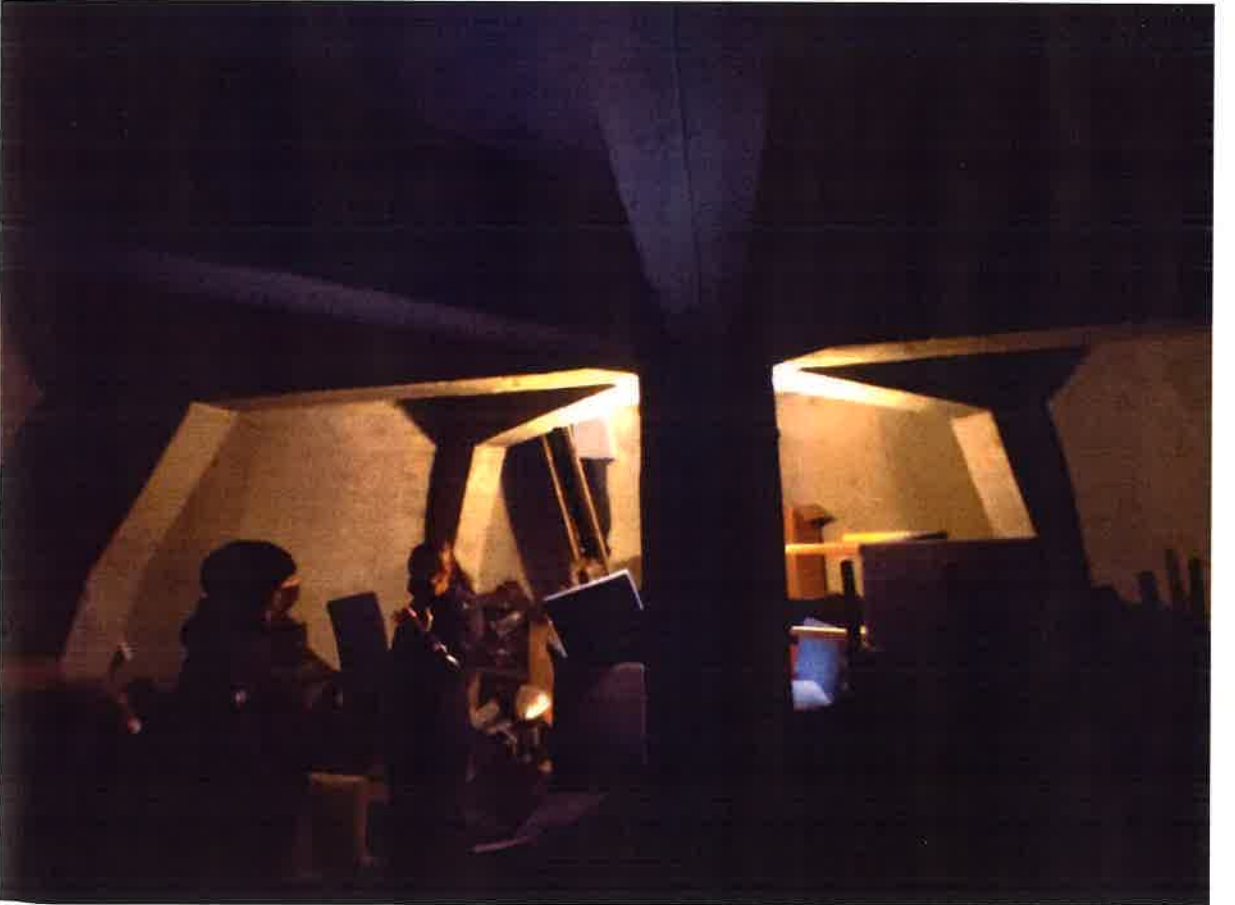
Fenerin birinci katındaki betonarme kolon ve kirişler
