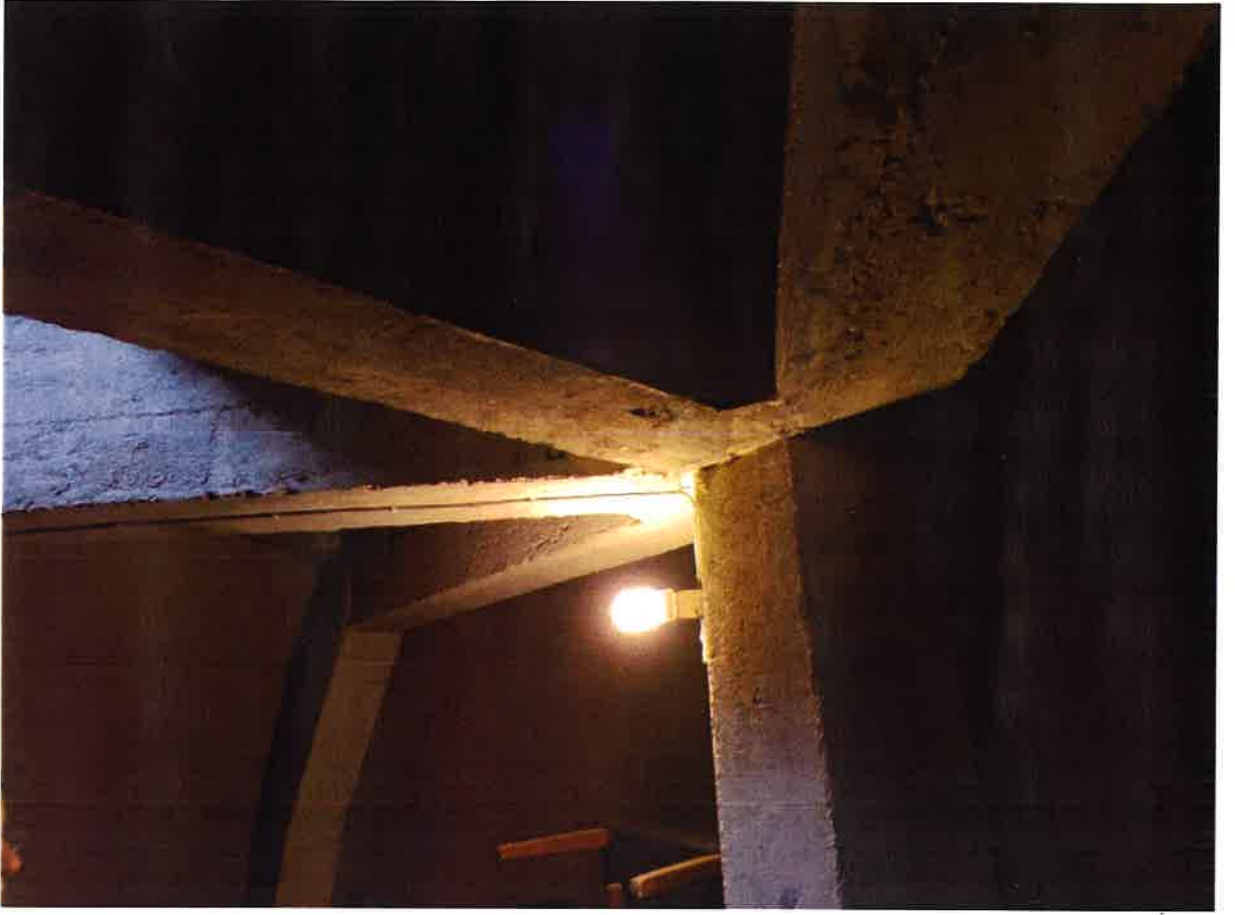
Fenerin birinci katındaki betonarme kolon ve kirişler
